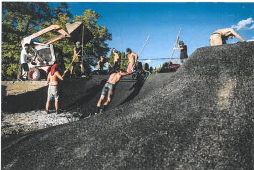
10. ábra (Aszfalt terítése kézi erővel)
