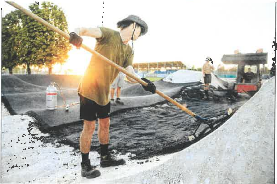
11. ábra (Aszfalt terítése kézi erővel)
