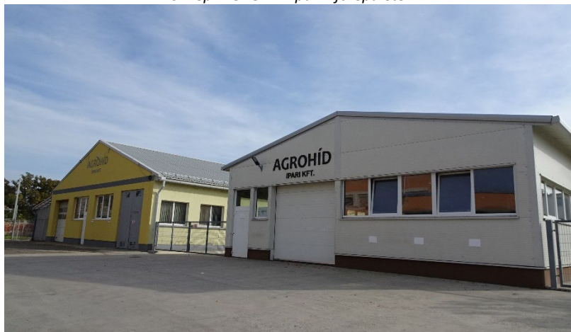
5. kép: AGROHÍD Ipari Kft. épületei
