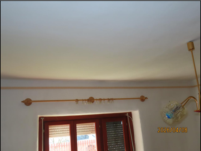
16. hálószoba fa födém szerkezet lehajlás
